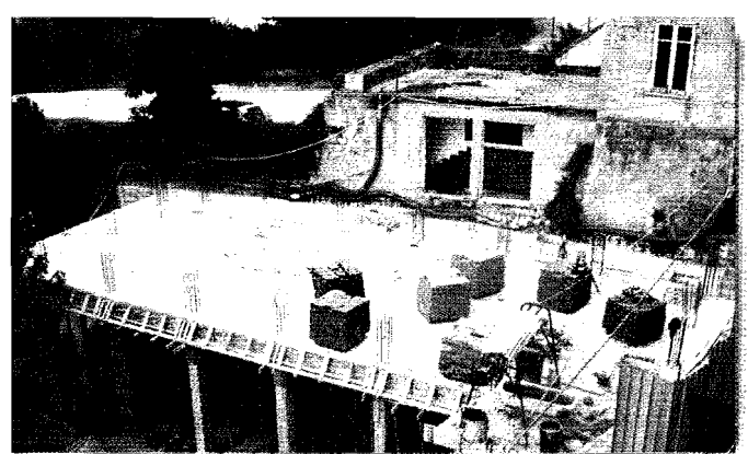
Il solaio di copertura dopo "la gettata"
