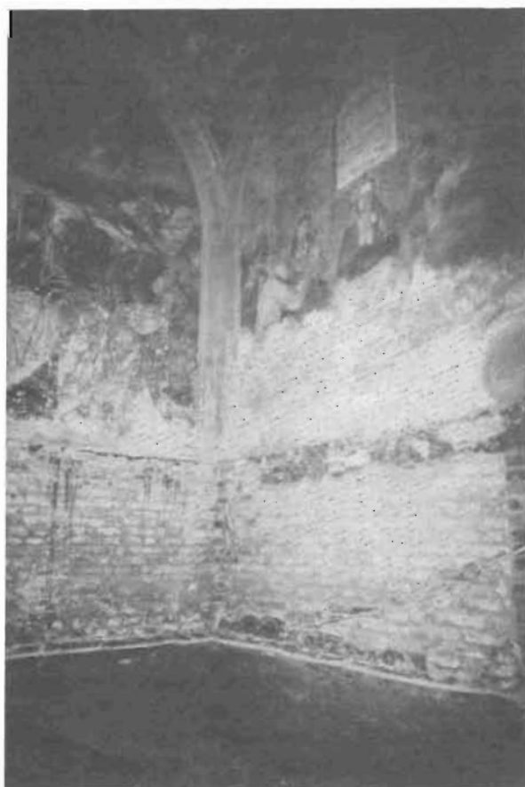
La Cappella dell'altare maggiore dopo l'asportazione delle lastre di rivestimento in marmo e a sbancamento eseguito.
